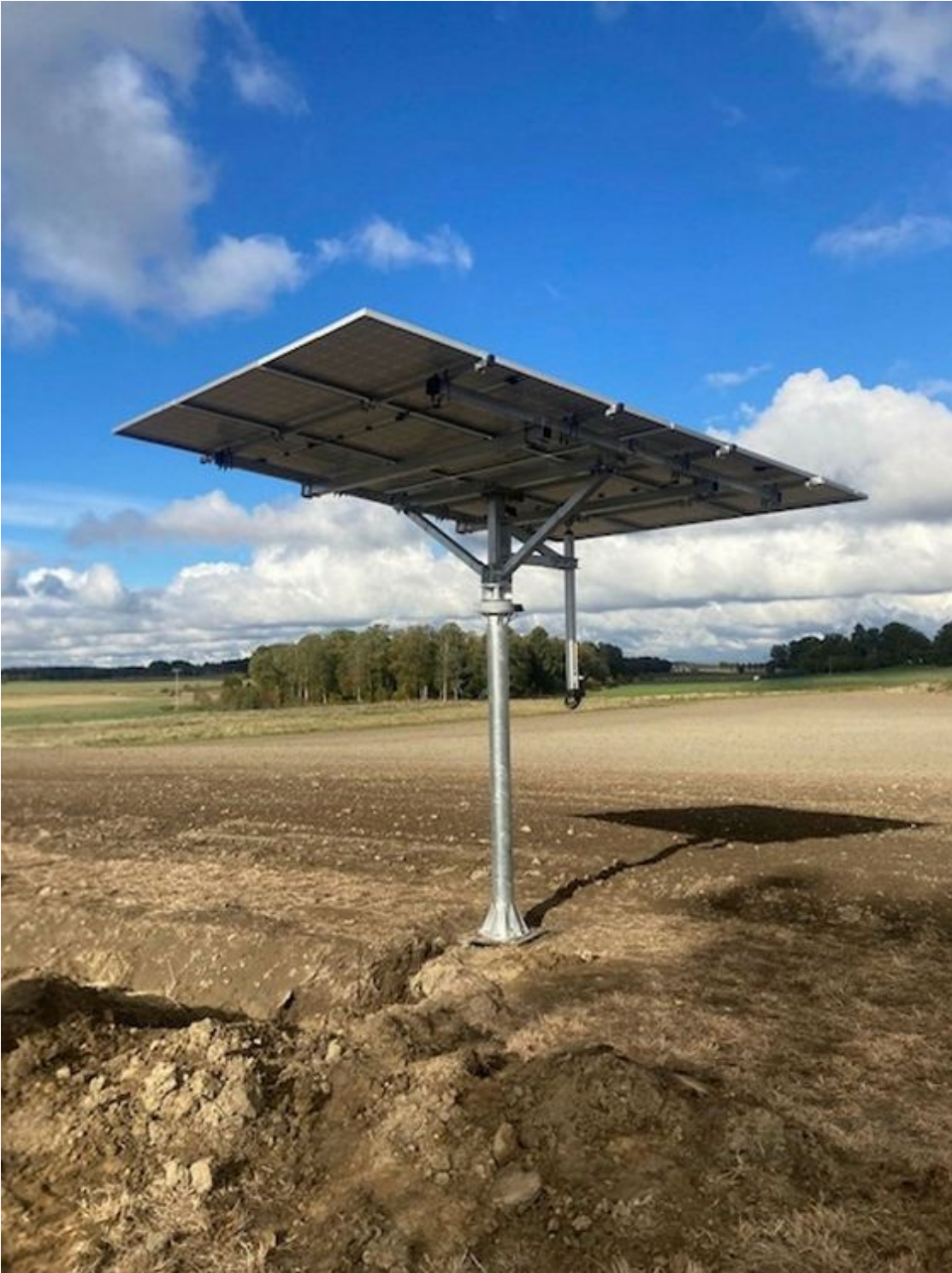
Vridbara solceller på åkern som följer solens färd över himlen för att få så mycket energi FOTO: CILLA KRANTZ
